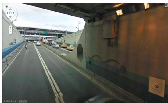
圖 10.2 臺北市松山區復興北路地下道之車道配置(內側禁行機車、外側混合車道)
