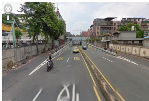
圖 10.3 新北市板橋區大觀路地下道之車道配置(內側禁行機車、外側混合車道)
