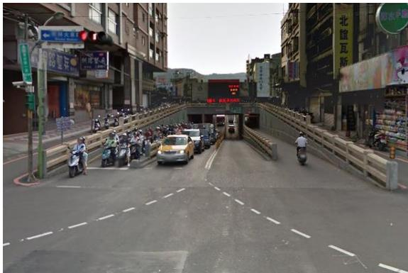
圖 10.7 新北市樹林區保安街一段地下道之車道配置(1 禁行機車道、1 機車專用道)
