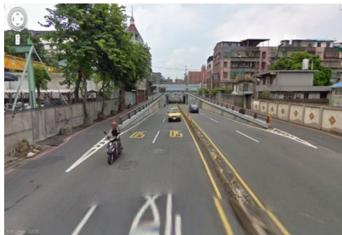
圖 10.3 新北市板橋區大觀路地下道之車道配置(內側禁行機車、外側混合車道)
