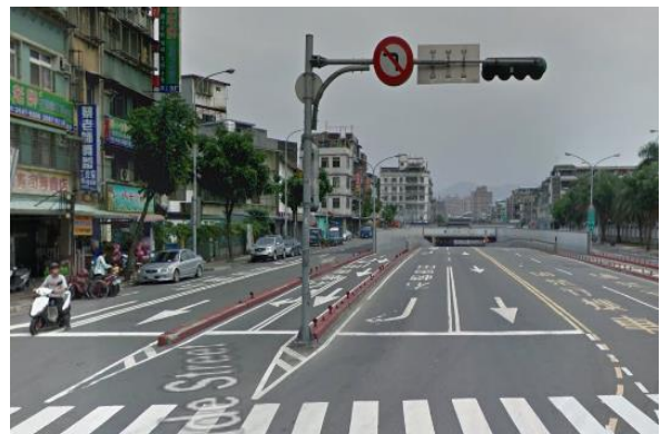
圖 10.8 新北市樹林區八德街地下道之車道配置(2 禁行機車道、1 機車專用道)
