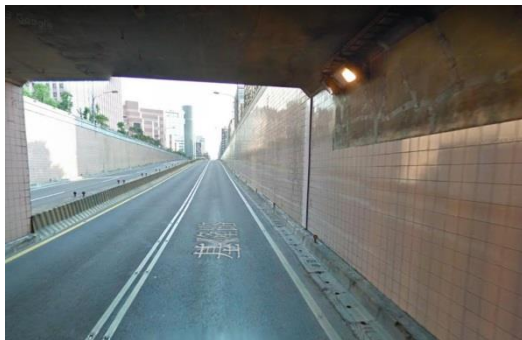
圖 10.1 臺北市信義區基隆路地下道之車道配置(2 禁行機車道)
